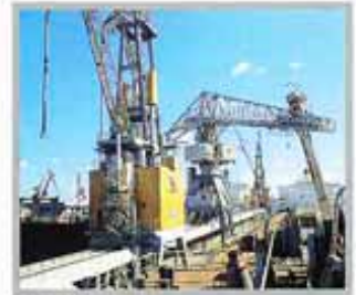
본선하역 Vessel unloading
