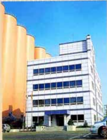
대한싸이로(주) 사옥 / Korea Silo Building
